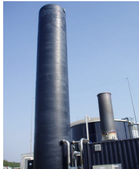
Abbildung 2: Fließbild eines biologischen Wäschers zur Rohbiogasentschwefelung; Abbildung eines biologischen Wäschers an der Biogasanlage Bruck/Leitha, Österreich mit einer Rohgaskapazität von 800m 3 /h (Quelle: Technische Universität Wien, Biogas Bruck GmbH)
