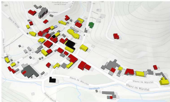
Gebäudebestand vor Projektstart
